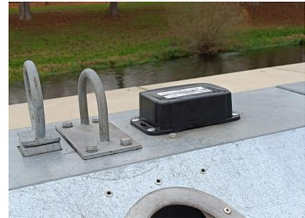
Mithilfe von Ultraschall ermittelt der Sensor den aktuellen Füllstand des Behälters. Die Daten der Sensoren werden über das städtische Netzwerk empfangen.
